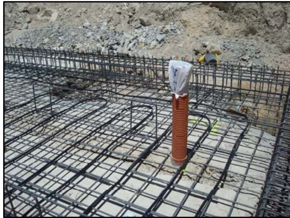
Detalle de las sondas geotérmicas en el borde de la viga perimetral
