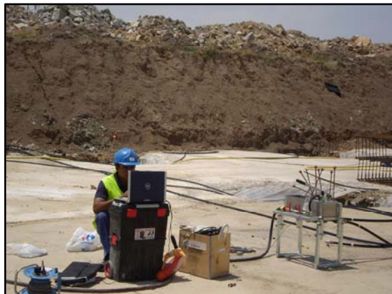
Pruebas de carga de instalación, realizadas en las sondas geotérmicas
