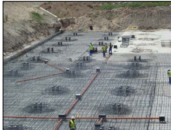
Vista parcial de la Losa de Cimentación Activa Jaén-España
